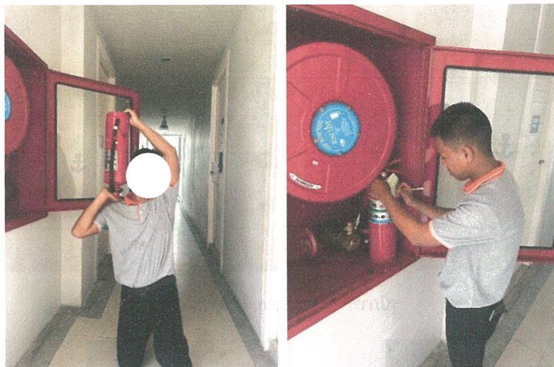
รูปภาพที่ 2.5 การตรวจสอบระบบป้องกันอัคคีภัยและระบบเตือนภัย
